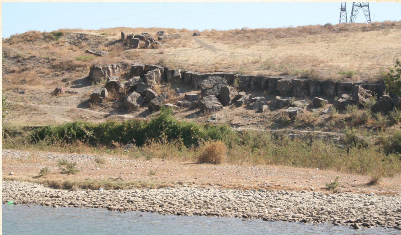
Основание средневекового каменного моста через р. Талас
